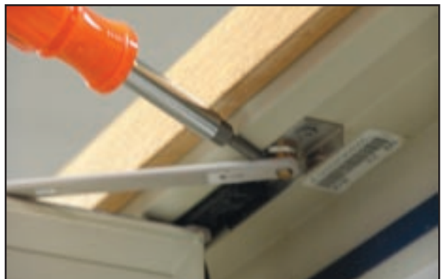
Unhooking the Upper Hinge
