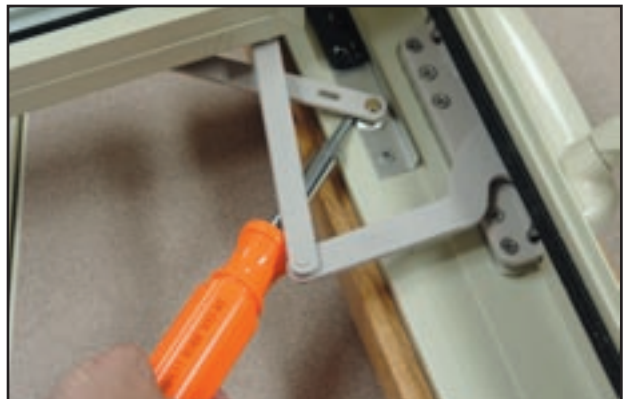
Unhooking The Lower Hinge
