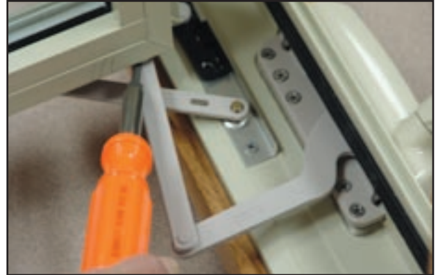
Unhooking the Stud Bracket
